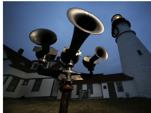
شکل (۳-۱۴) تصویری از یک بوق دریایی جهت ارسال اخطار به کشتی ها و شناورها جهت اجتناب از برخورد به صخره ها و یا موانع طبیعی و مصنوعی در آب و هوای مه آلود دریاها با استفاده از ارسال امواج و سیگنال های صوتی
